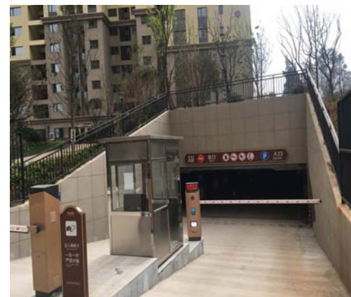
地下车库禁鸣限速标识
