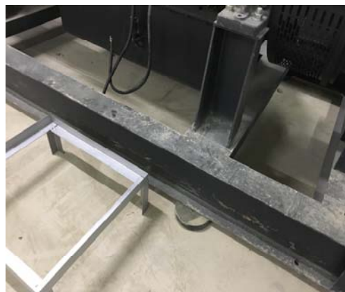
柴油发电机减震底座
