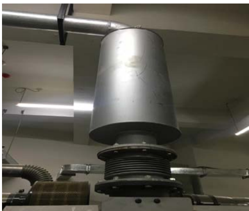
柴油发电机消声器
